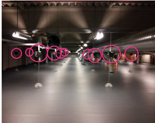
Fig. 1. The w-iLab.t Zwijnaarde testbed
